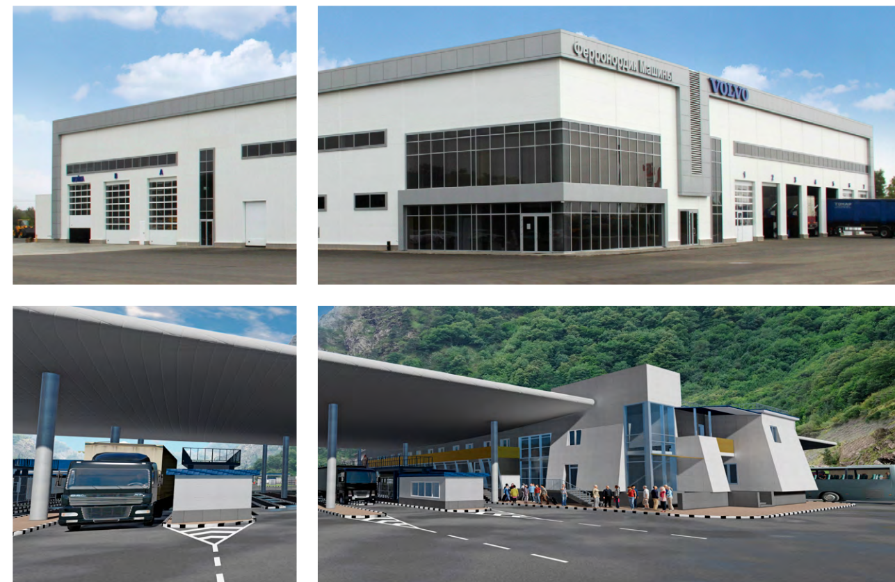
Сервисный центр дорожно-строительной и грузовой техники «Вольво», Республика Адыгея, Теучежский район Заказчик: ООО «Ферронордик Машины»
