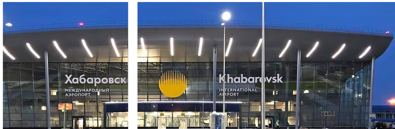
Воздушный пункт пропуска через государственную границу Российской Федерации в международном аэропорту Хабаровск, Хабаровский край (работы ведутся) Заказчик: АО «Международный Авиатерминал Хабаровск»
