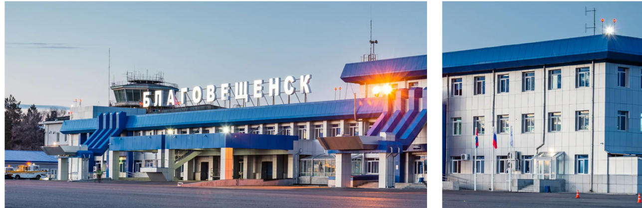
Воздушный пункт пропуска через государственную границу Российской Федерации в международном аэропорту Благовещенск (Игнатьево), Амурская область (работы ведутся) Заказчик: ФГКУ Росгранстрой
